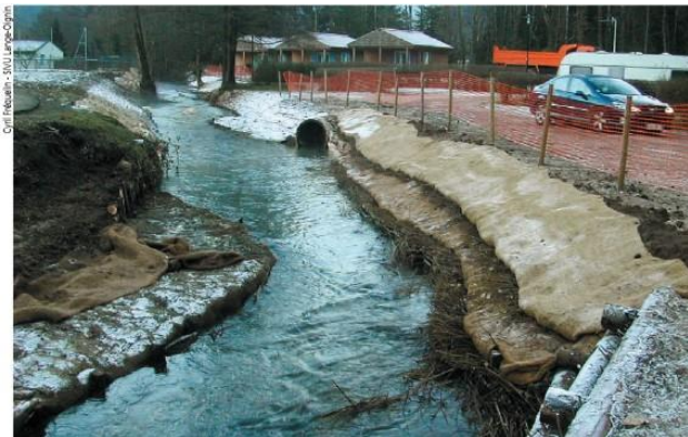
Création d'un chenal d'étiage sinueux par la pose de banquettes sur le Merloz, bassin Rhône Méditerranée. Décembre 2008.
