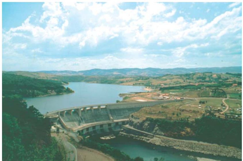
Barrage de Villerest (42)
