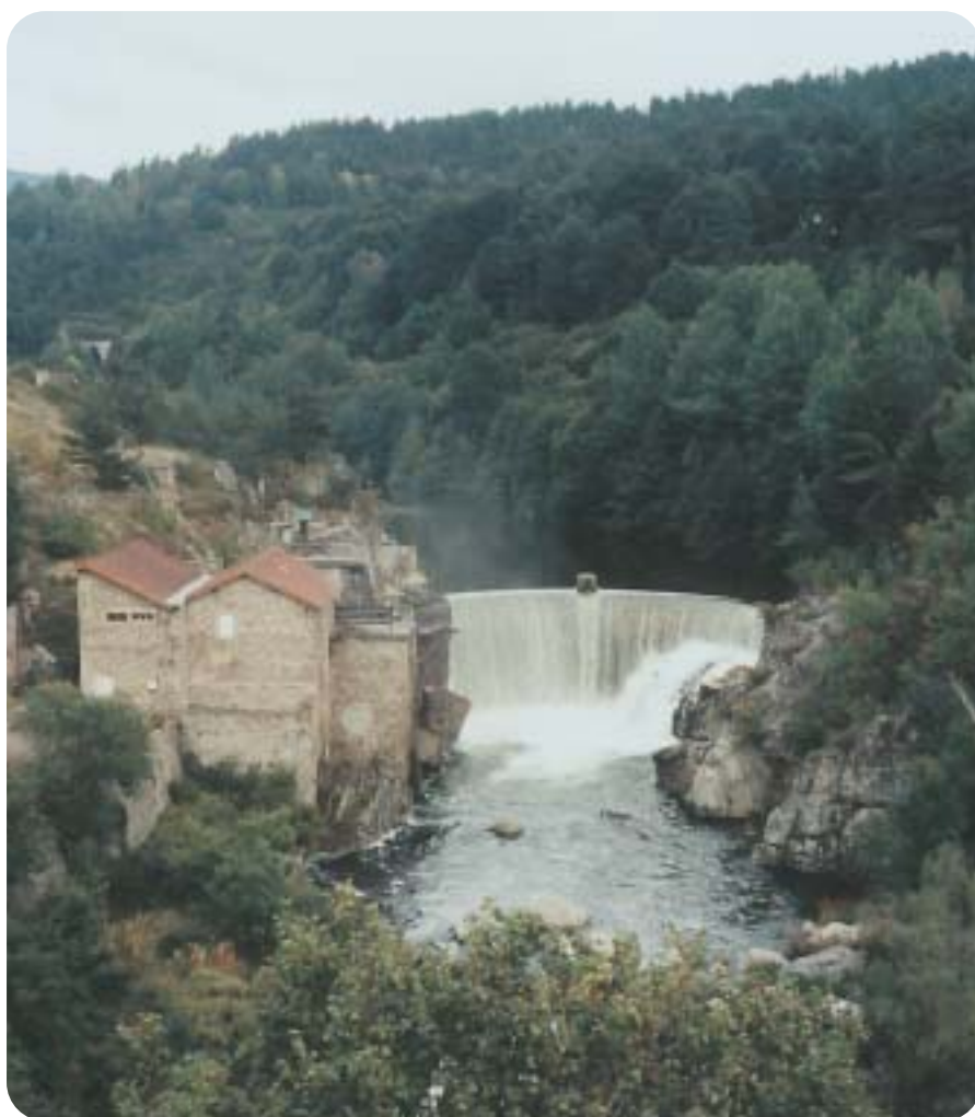
Saint Étienne du Vigan avant arasement
