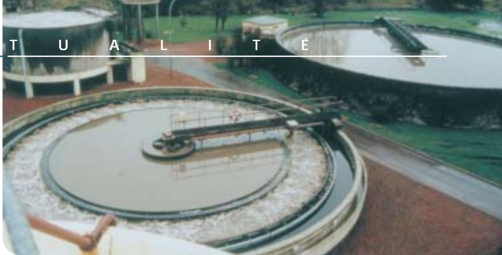
Clarificateurs d'une station d'épuration.
