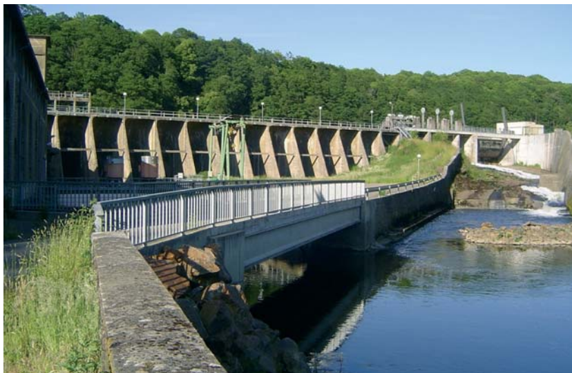
De même que le barrage d'Argentat sur la Dordogne est censé l'être pour celui du Chastang, le barrage de La Roche-qui-boit sur la Sélune a été créé comme «bassin de compensation» de Veziens. Mais il compense très peu et turbine beaucoup. Crédit photo : J-P Doron
